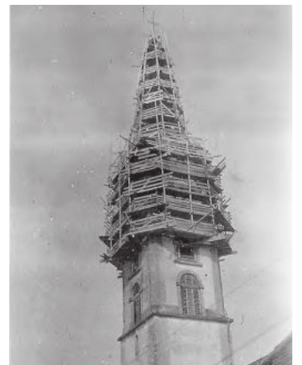
Sanierung des Turmhelms im Jahre 1934.
