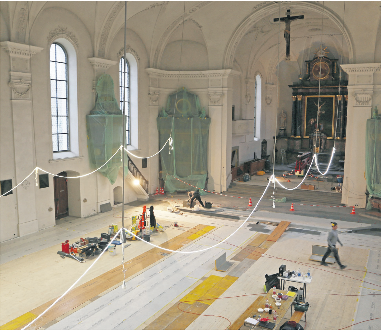
Das Innere der Kirche St. Stefan ist gegenwärtig eine Baustelle. Bis im Frühling saniert die Kirchgemeinde den Innenraum und erneuert das gesamte Möbiliar. FOTO GERI WYSS
