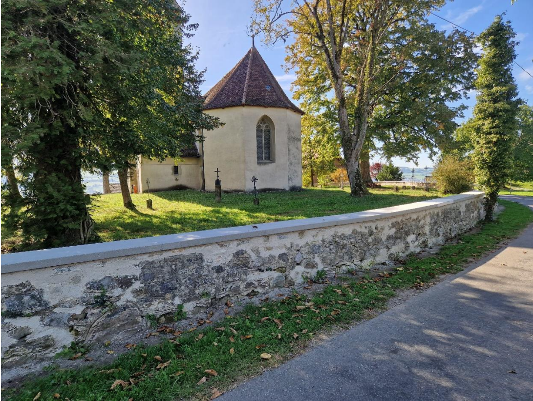
Die Ostseite der Umfriedungsmauer Kirchbühl nach der fachmännischen Restaurierung
