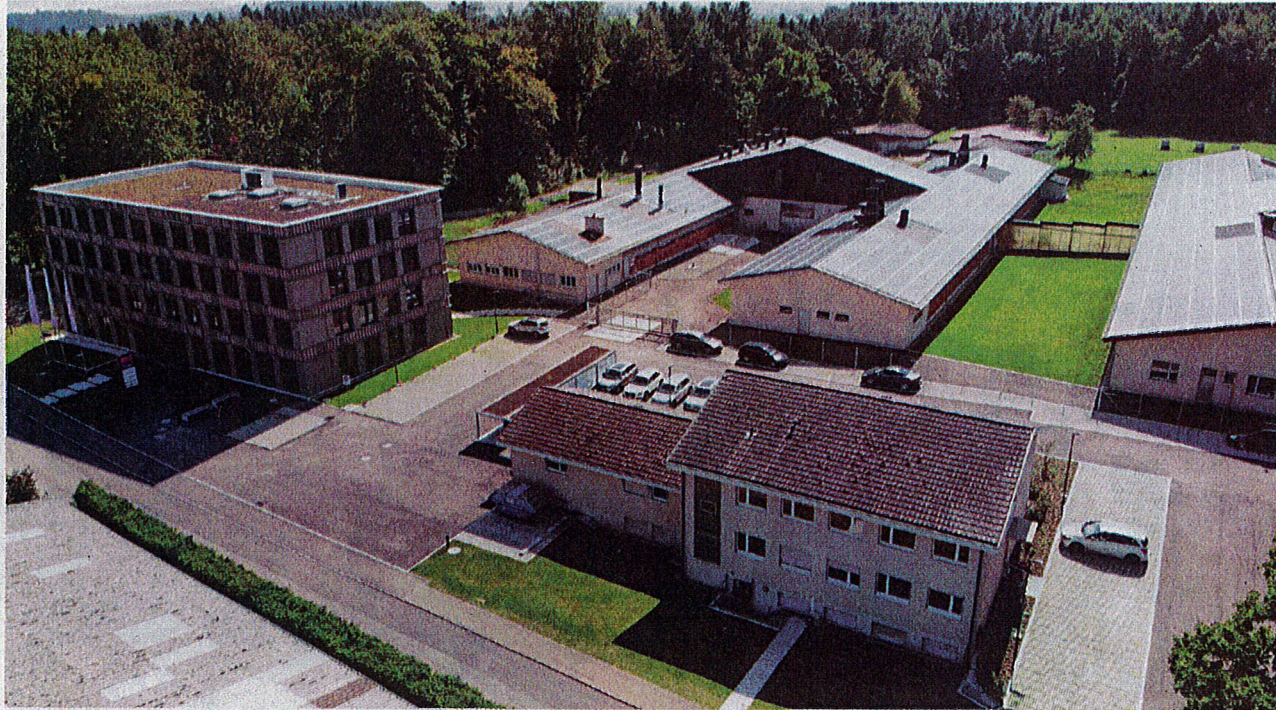
Auf dem Areal der Suisag wird eine temporäre Unterkunft für 52 Personen in Betrieb genommen.
